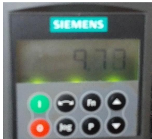
Рисунок 4.25 – Скорость вращения ротора, измеренная датчиком в Герцах
