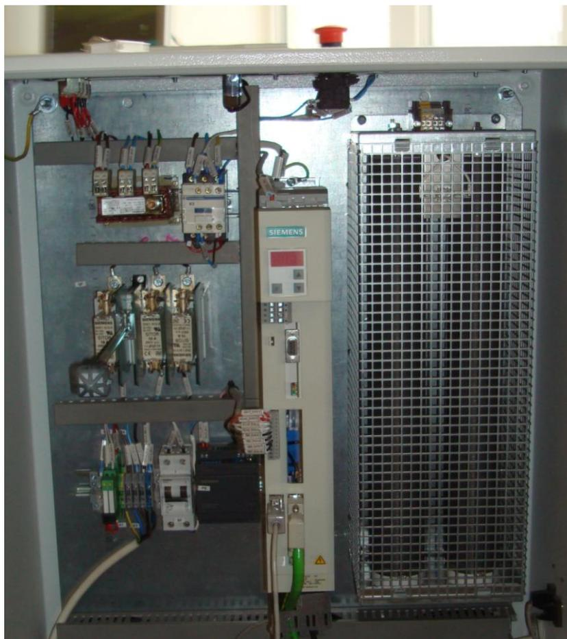
Рисунок 4.3 – Электропривод Simovert Masterdrives Motion Control
