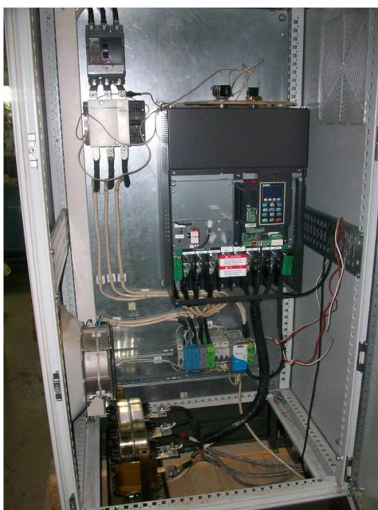
Рисунок Б.2 - Преобразователь частоты
